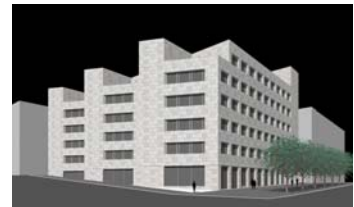
EDIFICIO CESTIC, SABADELL 2001
